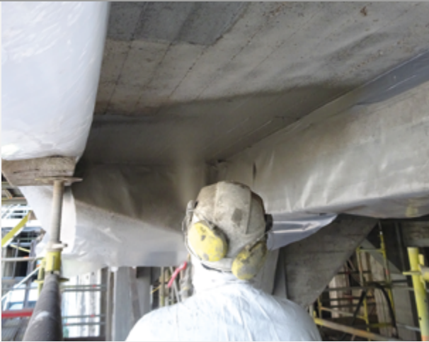
Aanbrengen van carbonatatie-remmende coating na betonherstelling.
